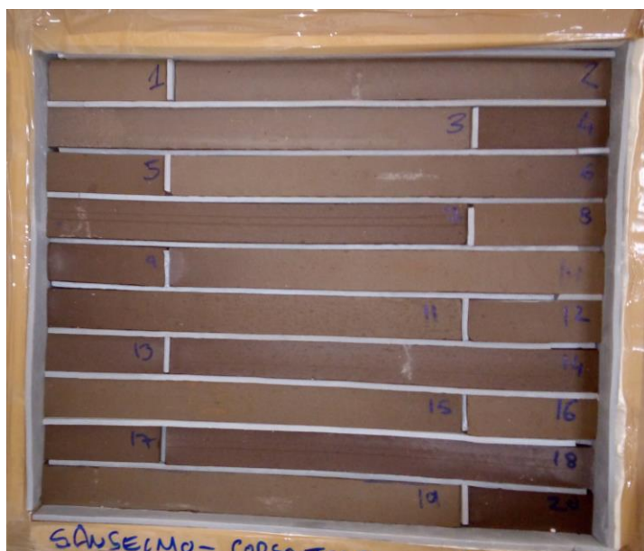
Pannello sottoposto a prova al termine dei cicli di gelo/disgelo Panel tested at the end of freezing/thawing cycles
